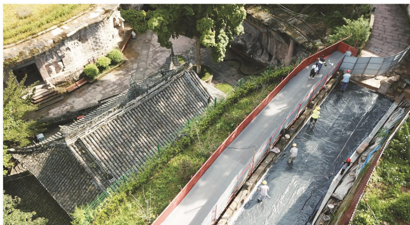
宝顶山大佛湾水害治理工程。(大足石刻研究院供图)
