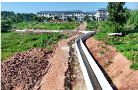
排洪沟改造工程加快推进。
