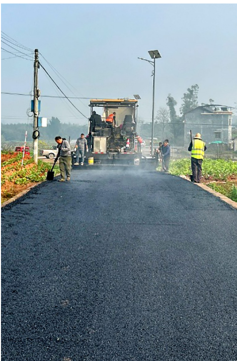
道路铺油硬化。
