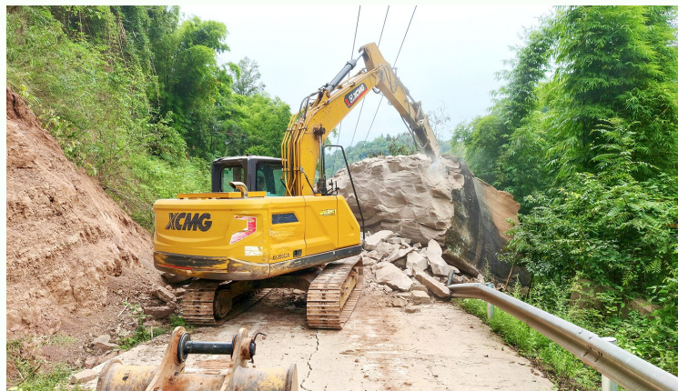
施工队作业现场。
