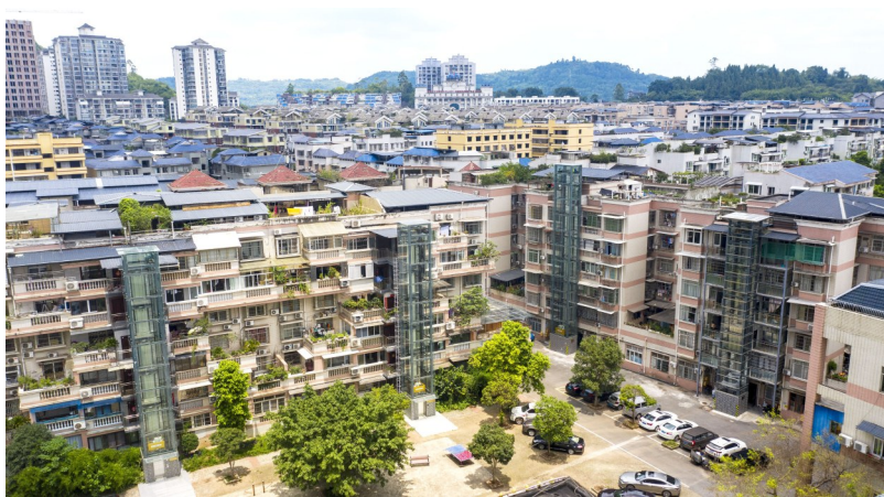
加装电梯后的老旧小区。
