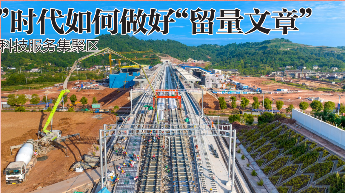
晨曦映照下的成渝中线高铁大足段施工现场一派繁忙。
