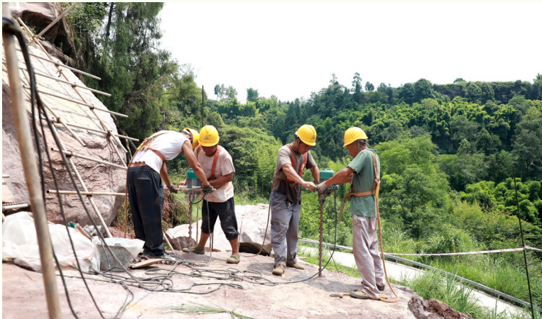
中敖镇排查整治危岩。大足融媒全媒体记者 邓小强 摄
