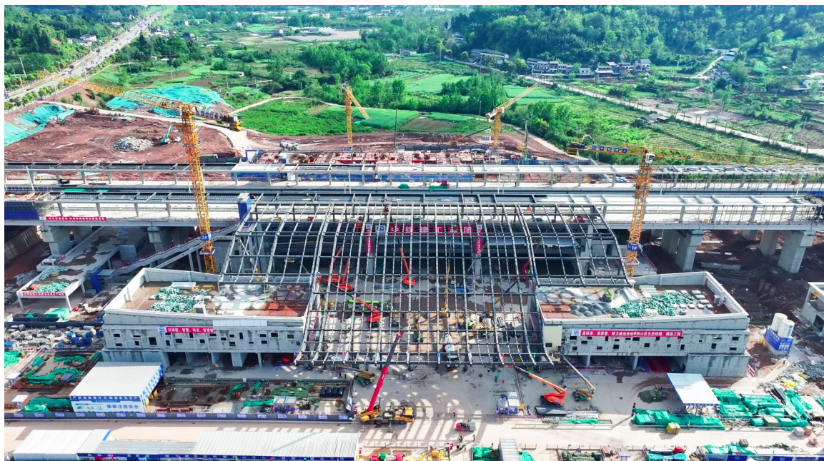
成渝中线高铁大足石刻站钢结构安装落幕。(资料图)
