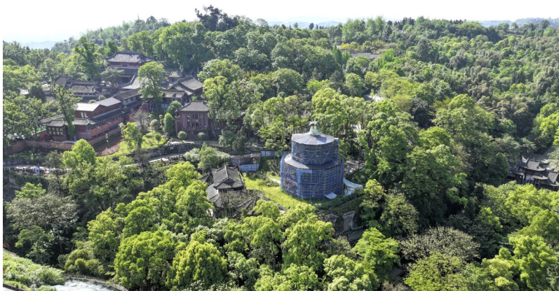
航拍下的宝顶山石刻景区万岁楼修缮工程。
